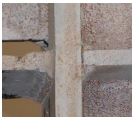
(d) Detail B, View from East
