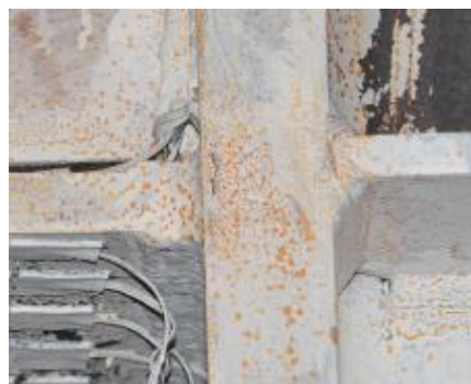
(d) Detail B, View from East
