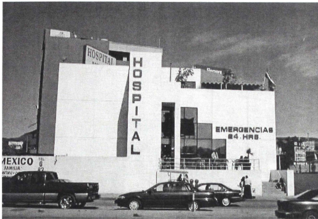
Foto 2. Hospital en la zona del cruce fronterizo de Tijuana
