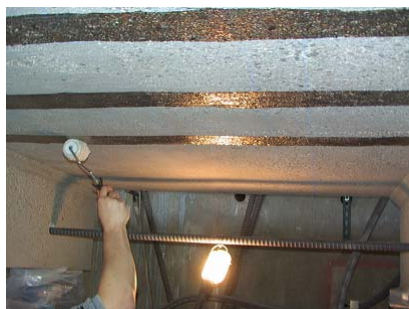
a) Application of primer coat
