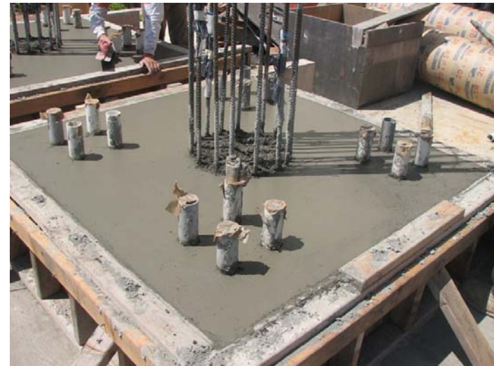
(d) Finished footing surface
