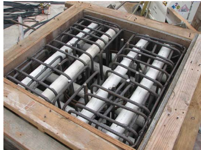
(d) Top block reinforcement
