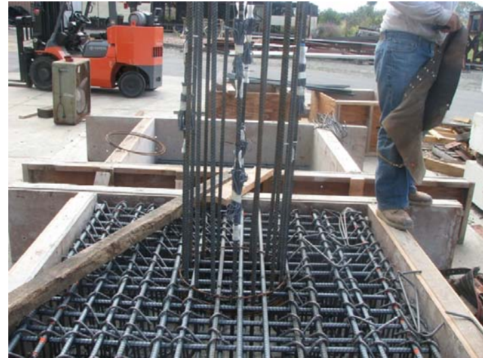
(d) Longitudinal reinforcement of the column
