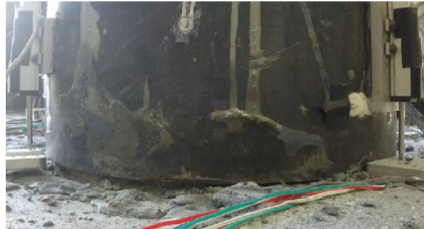
(d) South column interface, south side; end of excitation
