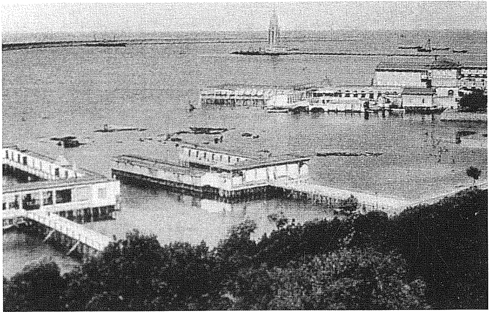
Fig. 13 - I primi stabilimenti balneari, anche per ragioni di sicurezza, crescono in genere a palafitte direttamente in mare (collezione E. Sturani, Roma)
