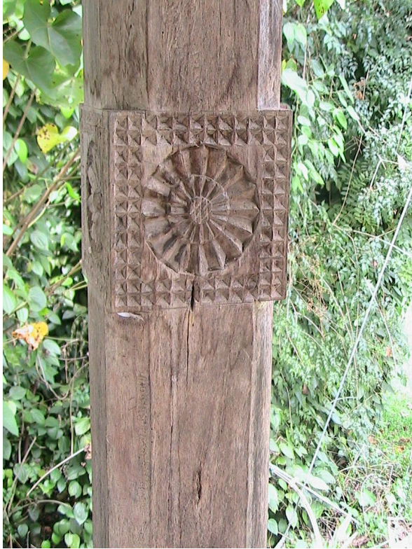
Fig. 4.51. Square-octagonal pillar, Simhâsana, Soragune Devâle
