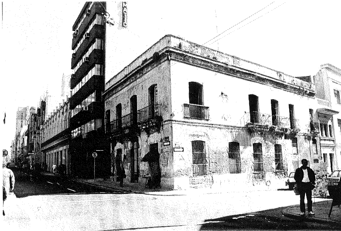
FIGURA 15.12 La Casa del General Manuel Oribe. Proyecto de puesta en valor en "Ciudad Vieja," Montevideo.
