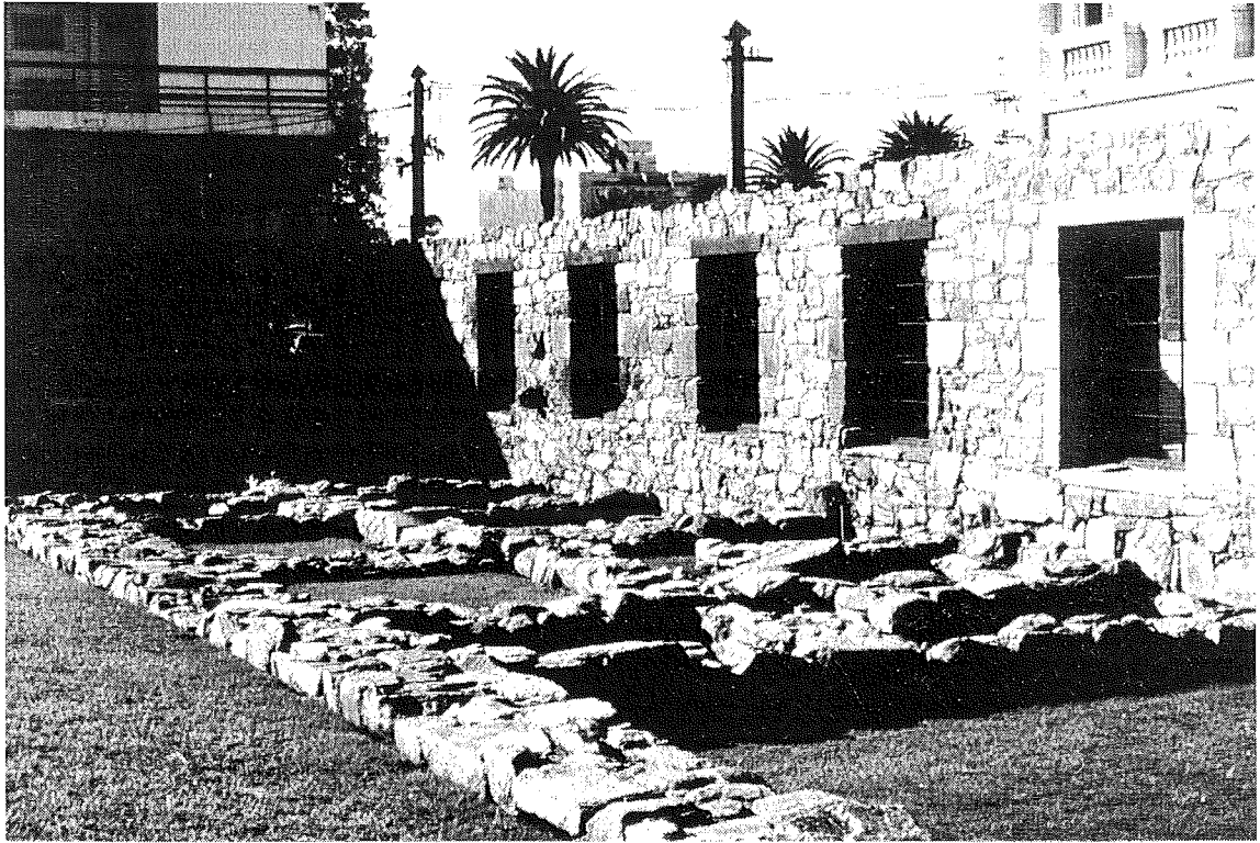
FIGURA 15.2 Cuartel de Dragones (Maldonado). Reconstrucción iniciada en el segundo período. Actualmente continúa en obras. Todas las fotografías son de la autora
