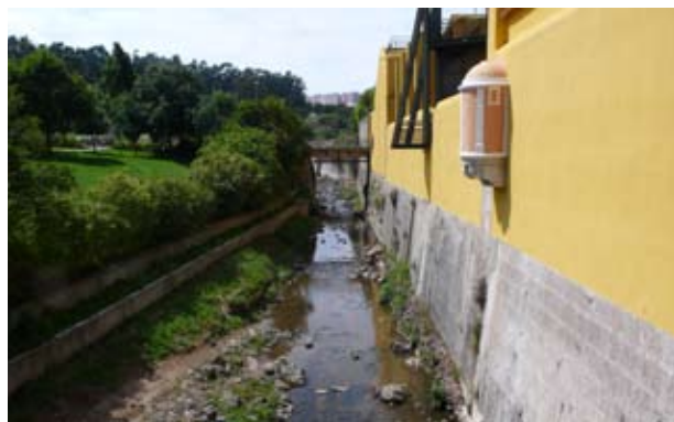
Ribeira dos Ossos at Fábrica do Pólvora
