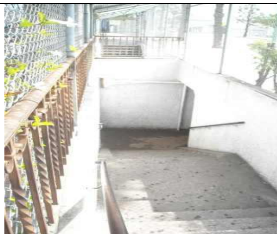
B6) Tunnel entryway view.
