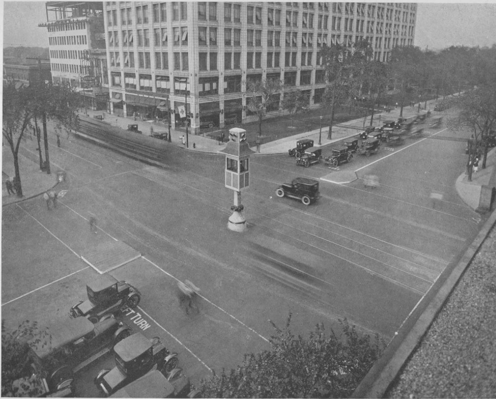
Pl. 3 — Nouveau type d'appareil de signalisation, Woodward Avenue et Grand Boulevard
