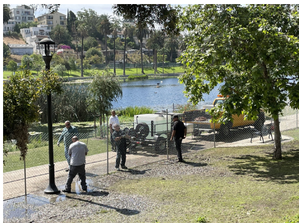
Figura 6-14. Trabajadores de la ciudad instalan vallas adicionales dentro de la valla perimetral, Echo Park Lake, 25 de mayo de 2021. Foto: Street Watch LA.
