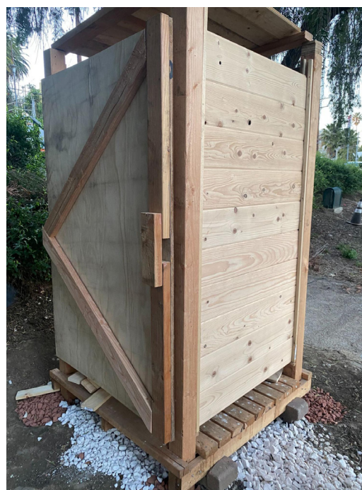
Figura 5-23. Regadera de agua caliente en Echo Park Lake. Febrero de 2021. Foto: Ashley Bennett.
