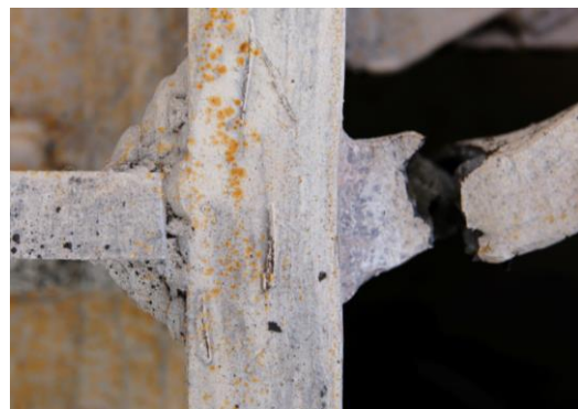
(d) West Beam Bottom Flange
