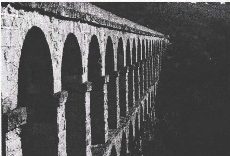
ACUEDUCTO VACIO TARRAGONA, ESPAÑA, 1996
