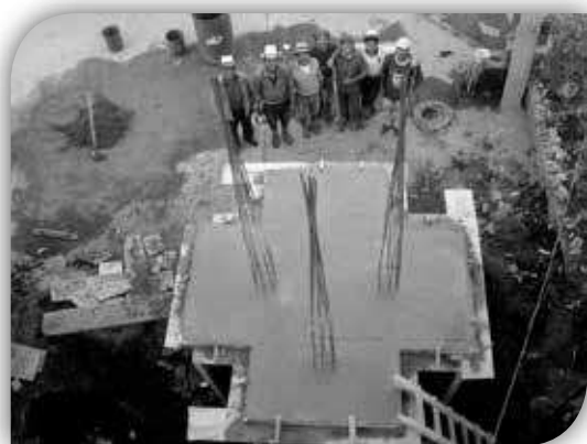
Fin de construcción de la base, 2012 Foto: María Regina Firmino Castillo
