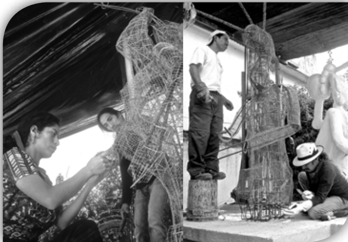
Instalación de armazón antes de la aplicación de cemento, con voluntarios Otto Ceto y Malb'alay Raymundo, 2013. Fotos: María Regina Firmino Castillo
