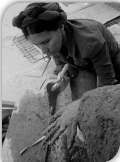
Aplicación de cemento sobre armazón y malla; Foto: Francisco Brito Cedillo
