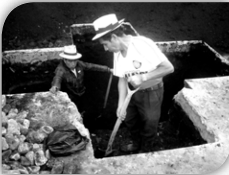
Excavación para cimiento del monumento, 2012 Foto: Tohil Fidel Brito Bernal
