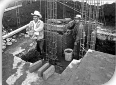
Instalación de barras de refuerzo. Pap Me'k' y Pap Xhas, 2012 Foto: Tohil Fidel Brito Bernal
