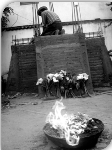
Nachb'al durante construcción de la base, 2013 Foto: Tohil Fidel Brito Bernal
