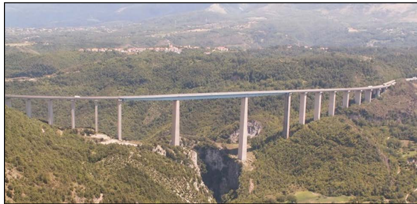
Fig. 1 Overview of the Viadotto Italia (Durante et al. 2018).
