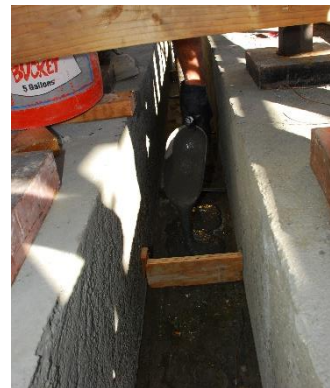
(d) Wall bed preparation
