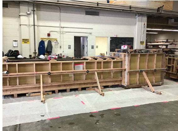
(d) Specimen prior to casting.
