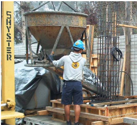
Figure 3-5: Column Base Concrete Pour
